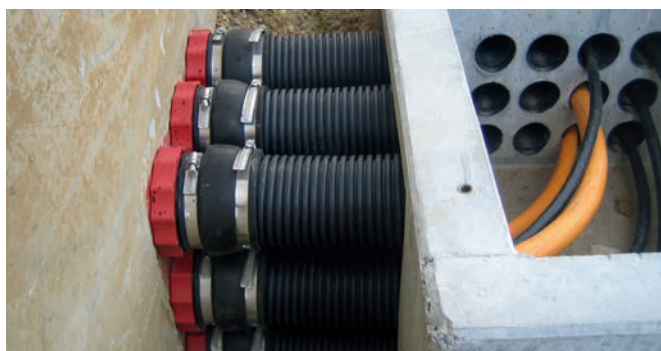
Raccord de tube annelé avec technique manchette HSI 150-M 168
