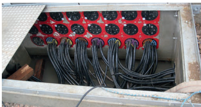
HSI 150 - passages étanches avec étanchéification SEGMENTO des lignes de commande dans un poste de commutation
