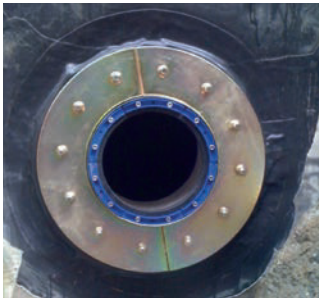
HRD 300-FUF/300-vz avec joint annulaire standard HSD-C (revêtu par poudre)
