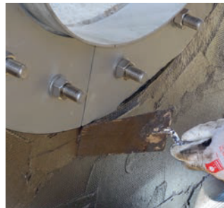
HRD 300-FUF/300 version acier inoxydable liée au revêtement bitumineux épais plastique modifié à l'aide d'une garniture d'étanchéité, voir page 37
