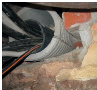
FZR-G 150/350 Travaux de rénovation
